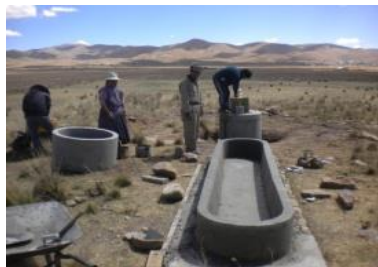
Foto: Construcción de bebedero en Municipio Collana 6
