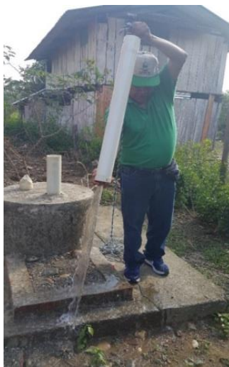
Foto: Pozo con balde manual PVC en Villa Tunari
