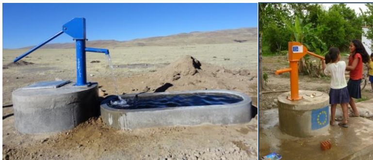
Foto: Pozo seguro y sellado con bomba tipo palanca (izquierda). Pozo después de la inundación en la cual se observa la protección del mismo de la contaminación
