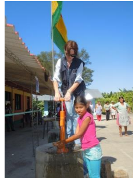
Fotos: Pozo sin cubierta donde se observa la contaminación del agua por hiervas, basuras y tierra (izquierda), pozo sellado y seguro con bomba manual tipo yacu (derecha).
